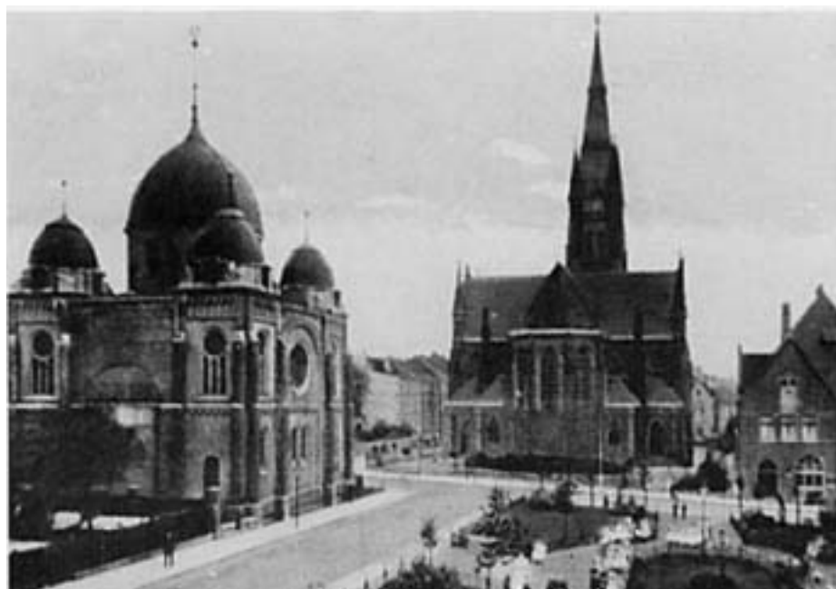
Die Hörder Synagoge neben der evang. Lutherkirche vor der Zerstörung in der Pogromnacht am 9. Nov. 38
